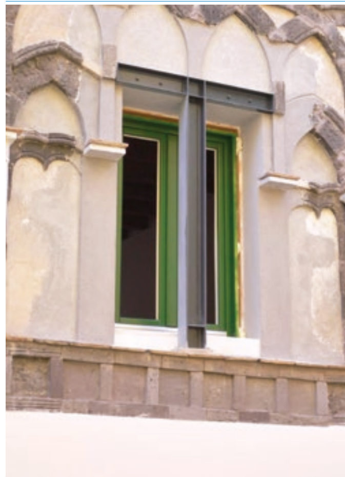
Finestra dopo l'intervento di restauro
